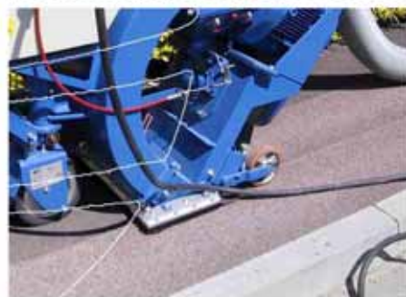
抛丸设备进行沥青路面改观处理
